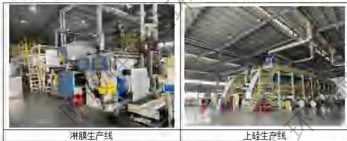
图 3.5-6 淋膜车间、上硅车间主要生产设施图
